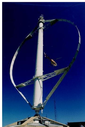
**Figura 4.1.1b** Aerogenerador Darrieus
